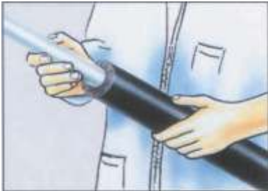
Encamise o Armaflex para tubulações retas
