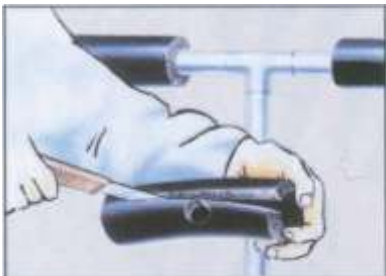
Seções em T: Corte longitudinalmente uma seção e faça um orifício do tamanho do diâmetro.
