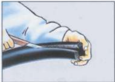
Para tubulações já instaladas, faça um corte longitudinal
